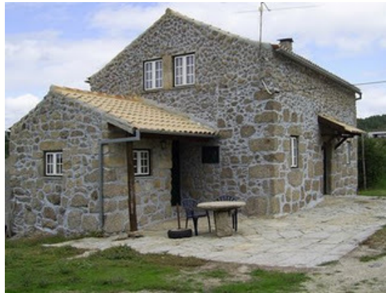
Casa de Granito – risco de concentrações elevadas de radão
