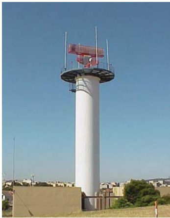
Radar de Lisboa LAT:38°45'50"N LONG:09°08'20"W Primário – 1030 MHz, 1,2 MW Secundário – 2760 e 2840 MHz, 2 KW
